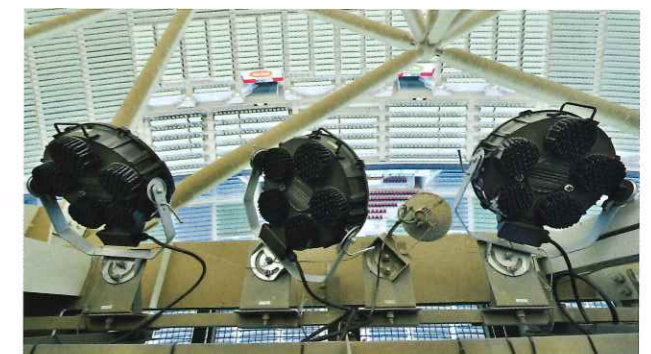
既設の取付架台を流用して配線工事を行い「レディオック フラッド デュエル」に更新している。 The existing stands were reused, and wiring work carried out to upgrade to LEDioc FLOOD DUELL lights.
